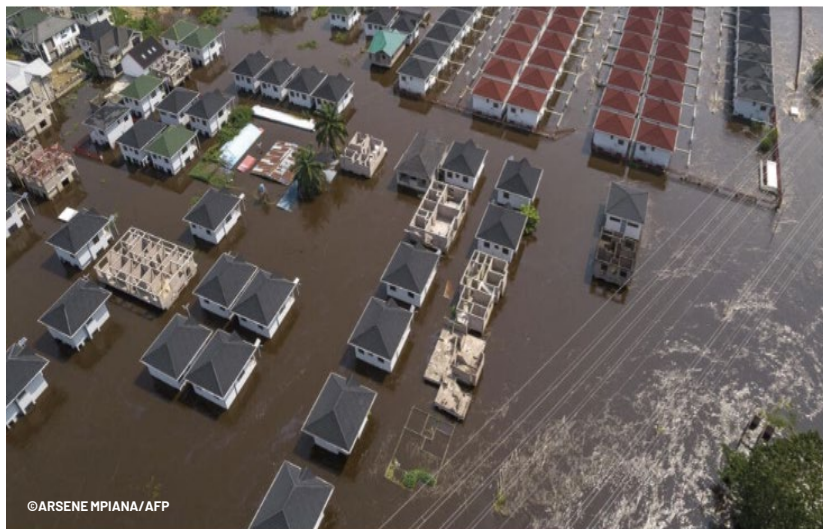
Vue aérienne dans le quartier de Mbudi à Kinshasa le 9 janvier 2024 suite aux fortes pluies et à la crue du fleuve Congo.
